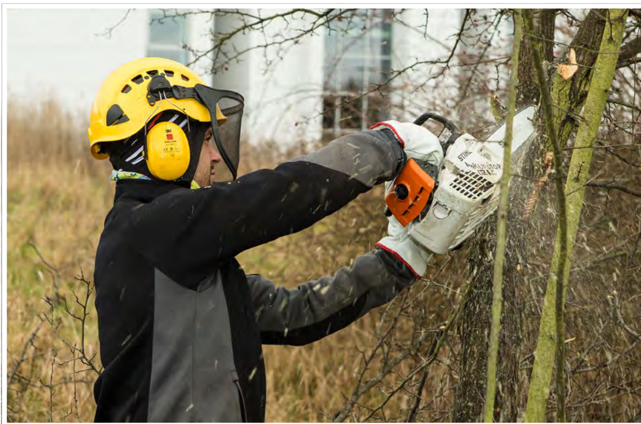
Příprava na druhou etapu budování univerzitního kampusu.
